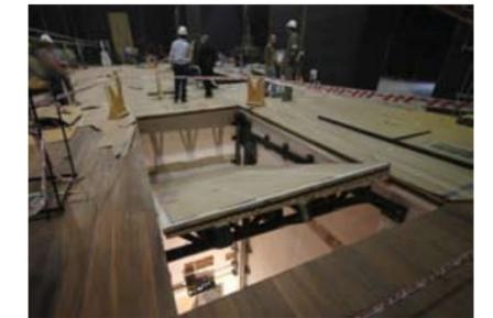
ESCENARIO: TAPA MECANIZADA. PLATAFORMA DEL MONTACARGAS N° 2.
