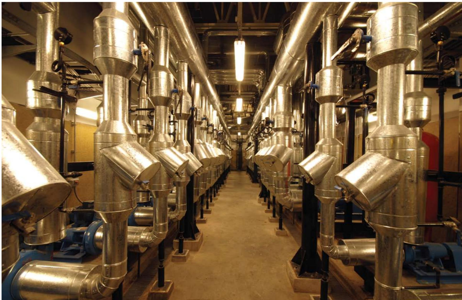
BOMBAS CENTRÍFUGAS PRIMARIAS EN LA CENTRAL TÉRMICA DE LA SALA DE MÁQUINAS PRINCIPAL.
