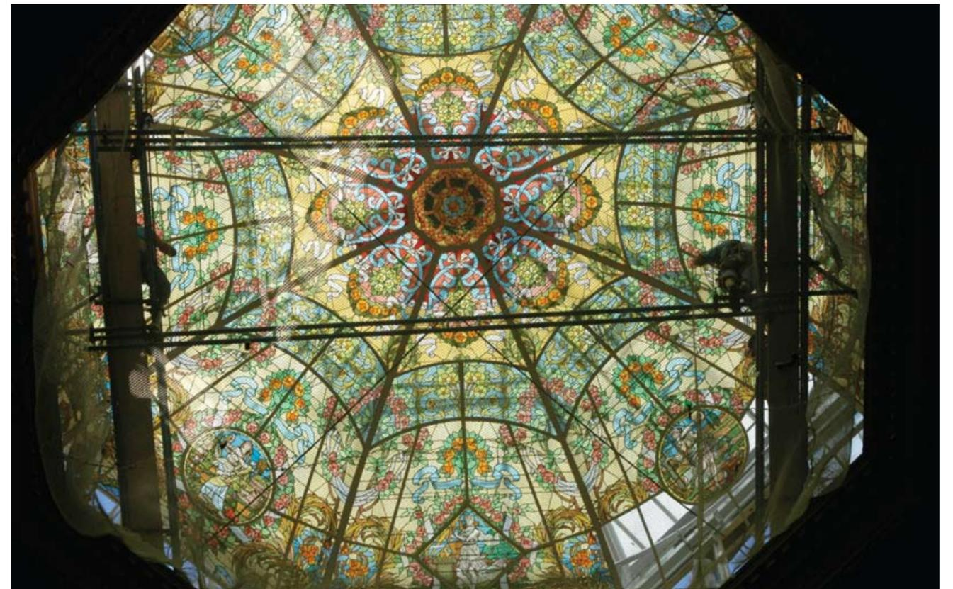
VITRALES DE LA CÚPULA CENTRAL CON ESTRUCTURA DE PROTECCIÓN DURANTE LA OBRA.
