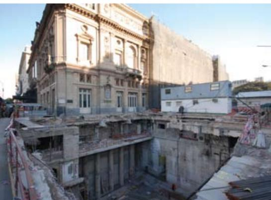
TRABAJOS DE SUBMURACIÓN MEDIANTE PILOTES Y UN MURO PANTALLA.
