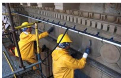
LIMPIEZA GENÉRICA DE LAS FACHADAS MEDIANTE EL MÉTODO DE NEBULIZACIÓN.
