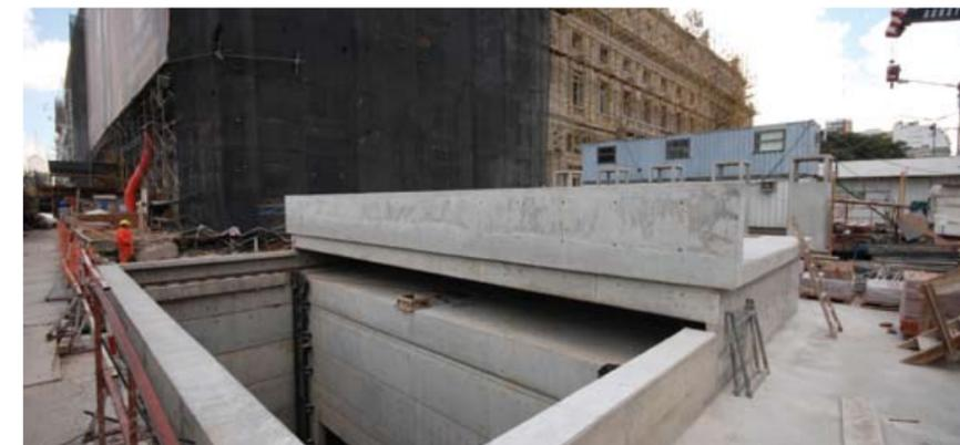
TRABAJOS DE SUBMURACIÓN MEDIANTE PILOTES Y UN MURO PANTALLA.
