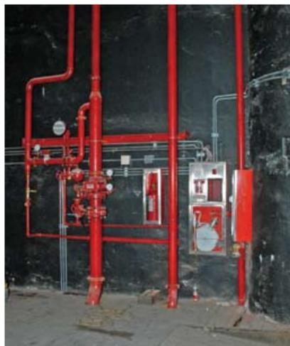
VISTA DE UNA ESTACIÓN DE CONTROL Y ALARMA (ECA) Y UNA BOCA DE INCENDIO EQUIPADA (BIE) EN CAJA ESCÉNICA, NIVEL ESCENARIO.
