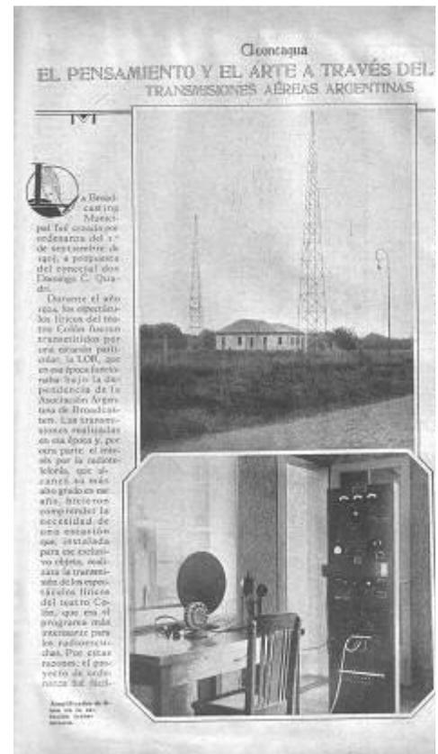
Amplificador de línea en la estación transmisora
