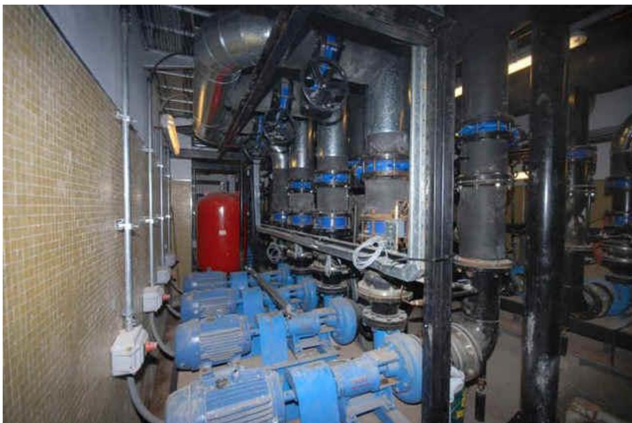
Obra de actualización tecnológica, Central Térmica, Sala de Bombas, Abril – Marzo, 2010. Foto: UPE. Estas fotos corresponden al nuevo sistema de acondicionamiento de aire y agua, forman parte de la Central Térmica del Teatro Colón. Estas máquinas permiten que el aire y el agua se enfríen o se calienten para climatizar los ambientes según la época del año y adaptarse a las necesidades. - Abril 2010
