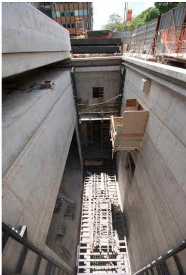
Reforma Escenotécnica - Pasadizo y guías verticales de desplazamiento del montacargas, este montacargas conecta el salón multipropósito con el nivel de la vereda para el traslado de escenografía y otros materiales de gran estructura. Noviembre y Diciembre, 2009. Foto: UPE.
